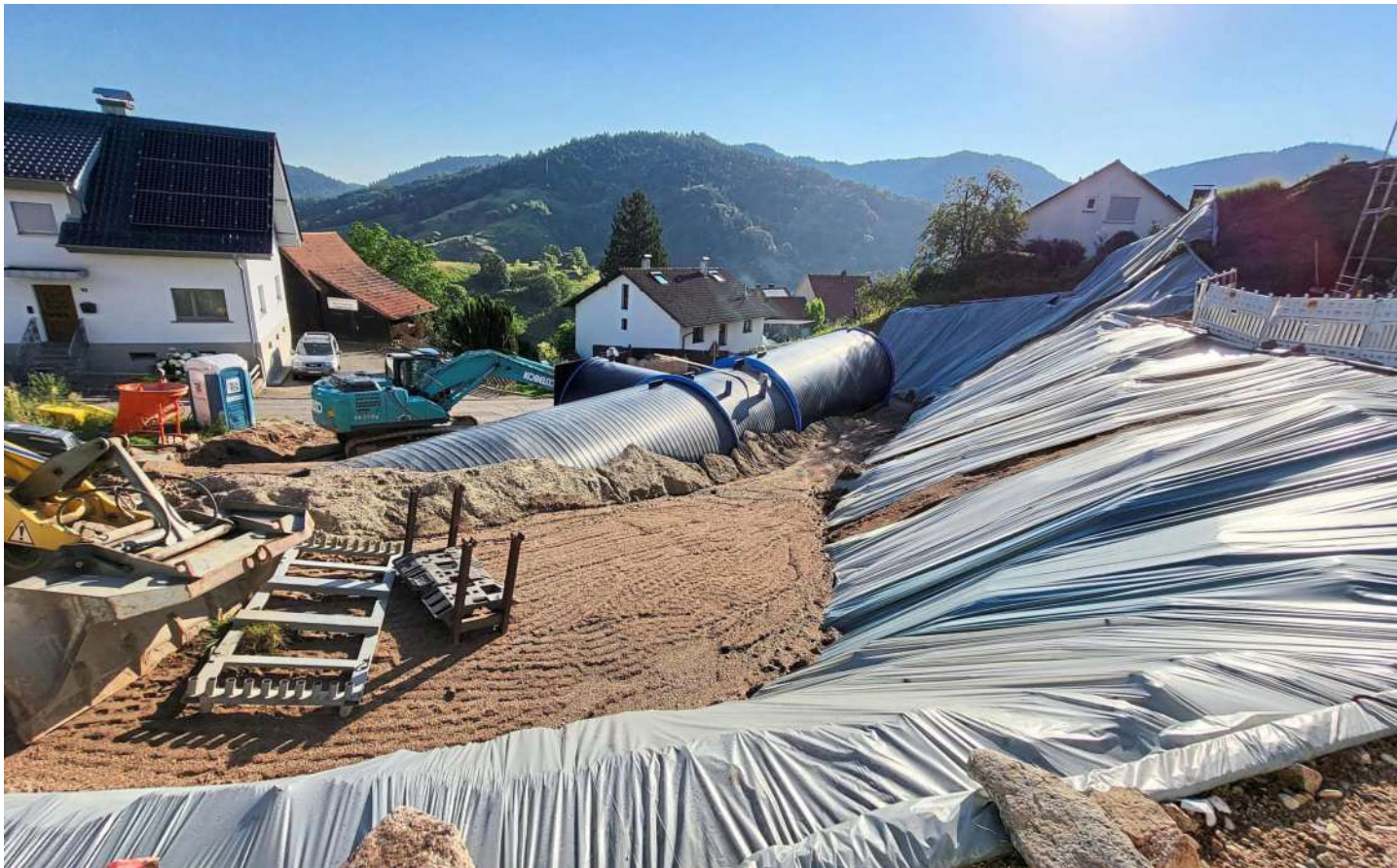
Für den neuen Hochbehälter hat die Gemeinde Bühlertal Kosten in Höhe von 1,05 Millionen Euro eingeplant. Am Ende wird die Baumaßnahme etwa 70.000 Euro teurer werden.
